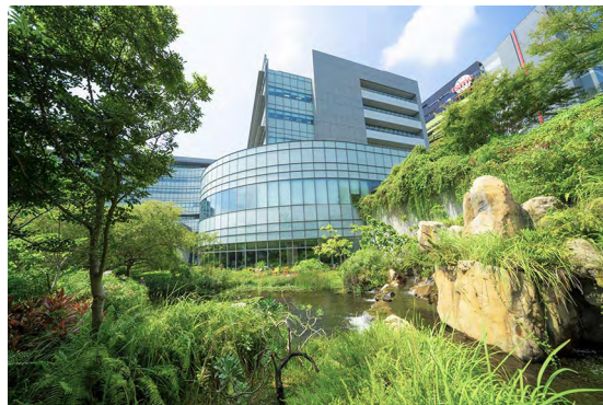
台積公司打造綠建築認證廠房
