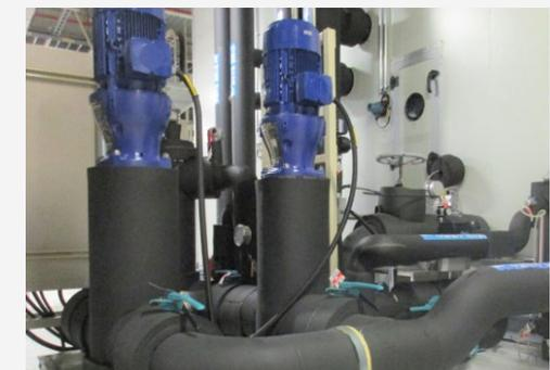
外氣空調箱洗滌加濕系統改裝濕膜板後，可減少洗滌水泵 80% 用電量
